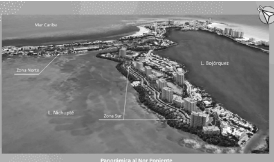
Panorámica al Nor Poniente
